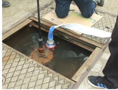
ホースを消火栓に取付
