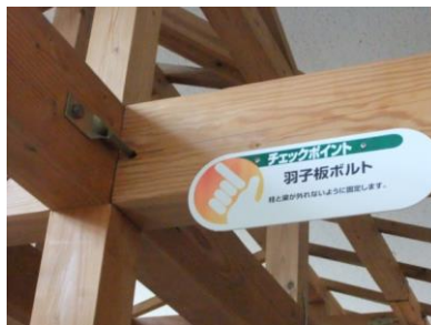
羽子板ボルトで柱と梁を補強
