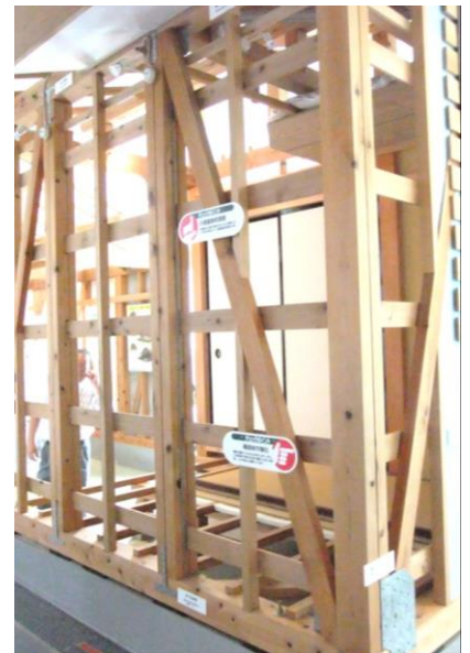
柱と壁の補強
