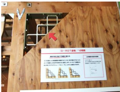
金具にて耐震補強
