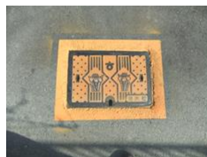
消火栓縁取り(該当消火栓)
