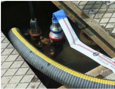
ホースを消火栓に取付
