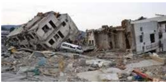
東日本大震災の爪跡
